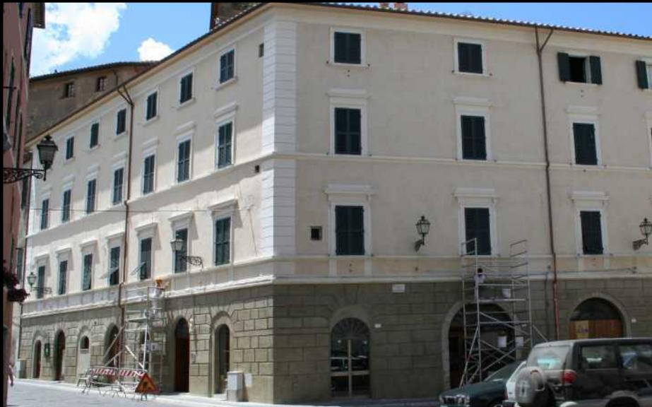
*En haut, à gauche: palais Sadun de la fin du XVIIIème siècle à Pitigliano. l'appareillage en moellons ordonnés, les encadrements et les plate-bandes ont été travaillées en stuc imitation pierre. Restauration des façades, du pavé de la cour intérieure et des toitures (2006-2007).
